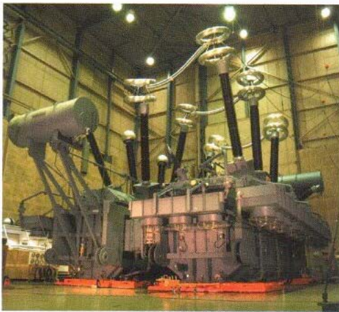
مدار تست القایی سه فاز به همراه اندازه گیری تخلیه جزئی
