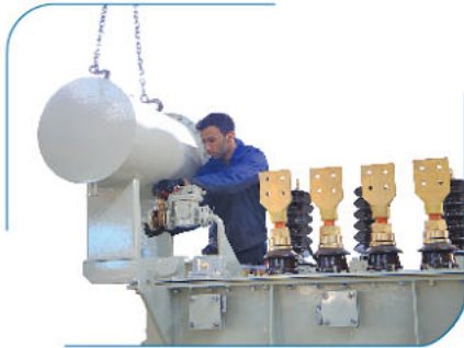
شکل ۳-۱۳ نحوه نصب منبع انبساط
