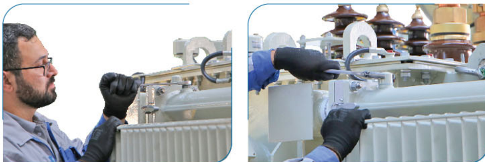
شکل ۳-۱۶ نحوه آچارکشی رادیاتور
