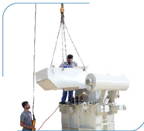
شکل ۳-۱۴ نحوه بلند کردن جعبه کابل
