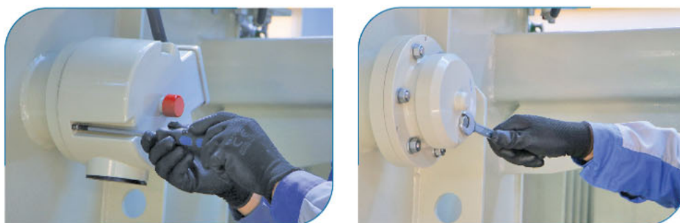
شکل ۳-۱۹ نحوه هواگیری فشارشکن
