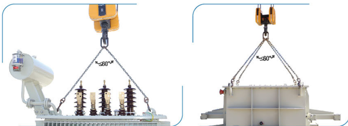
شکل ۳-۱ بلند کردن ترانسفورماتور
