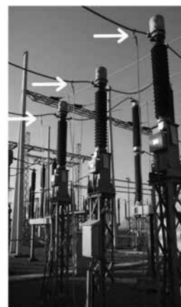
شکل پنج: برقراری اتصال زمین
