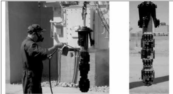
شکل ده: شستشوی اولیه سلکتور سوئیچ
