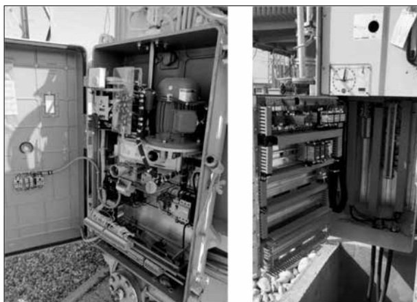
شکل بیست و سه: تست رله های موتور در ایو
