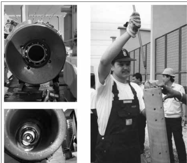
شکل دوازده: کربن زدایی از استوانه‌ی عایقی سلکتور سوئیچ
