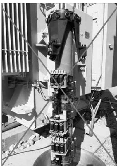
شکل سه: شستشوی تپ‌چنجر، سرویس محسوب نمی‌شود.
