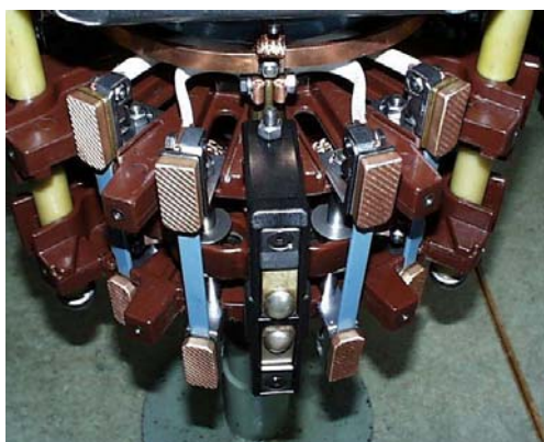
شکل ۷: کنتاکتهای مربوط به تپ چنجر مدل V و M
