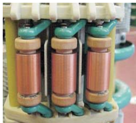
شکل ۷: کنتاکتهای مربوط به تپ چنجر مدل V و M
