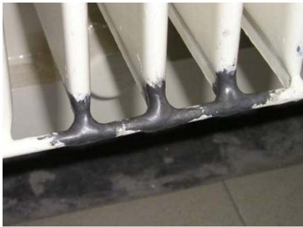
شکل پنج: نمونه رفع نشتی انجام شده بر روی رادیاتور ترانسفورماتور
