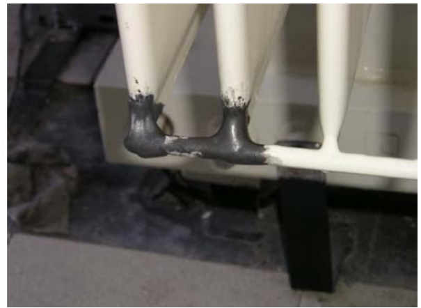
شکل پنج: نمونه رفع نشتی انجام شده بر روی رادیاتور ترانسفورماتور
